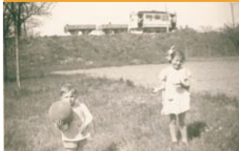
Tramway sur le talus au niveau de l'écluse 84.
